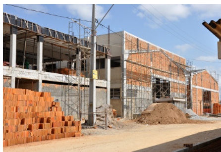
Galpão Topografia e Eng. Mecânica
