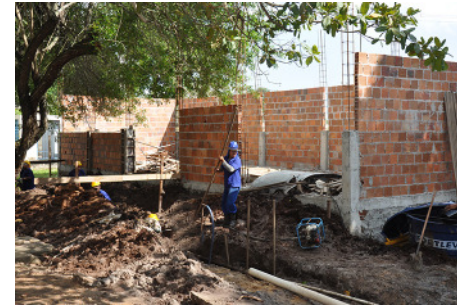
Estação de Tratamento de Esgoto
